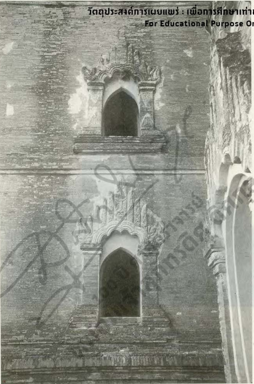
ภาพที่ ๒๖ หน้าต่าง ซึ่งมีซุ้มประดับแถวครึ่งสูง มีชื่อเรียกว่า เคล็ก-clec-จาก ภาพที่ ๒๕ เจดีย์วิหารธรรมยาจี้ (Dhammayangyi Temple) เคล็ก มีทั้งหน้าต่างและประตู (ดูภาพที่ ๒๘) อันเป็นลักษณะเฉพาะในศิลปะ พุกาม เป็นแรงบันดาลใจสำหรับงานประดับซุ้มของช่างล้านนาและงานช่างสุโขทัยด้วย (ดู ผนวกท่าย ๖ ก, ข)
