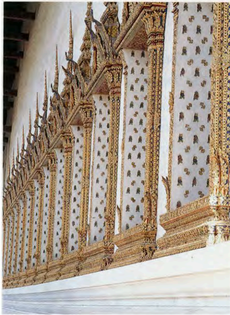
ซุ้มหน้าต่างพระอุโบสถปูนปั้นปิดทองประดับกระจกสี ซุ้มบันแถลงสองชั้น ยอดทรงพิชัยมหากุญ พื้นผนังด้านข้างบาน (ด้านนอก) ติดกระเบื้องเคลือบรูปดอกไม้ไม้ร่วง
