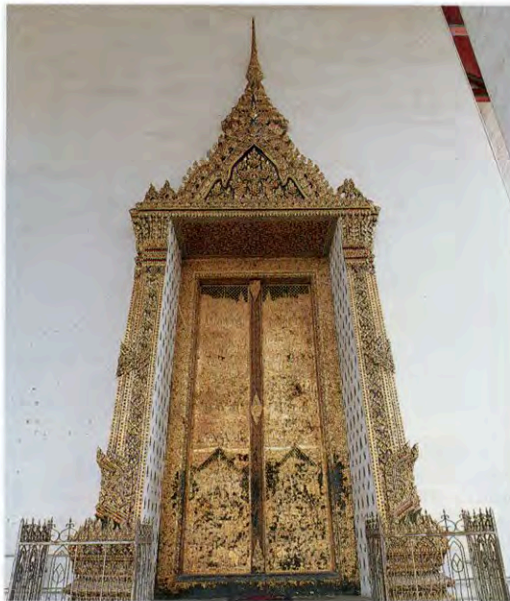
บานและกรอบซุ้มประตูพระอุโบสถ บานประตูไม้ลายรดน้ำเมืองสุทิสสนครเมืองของพระอินทร์ บนสวรรค์ชั้นดาวดึงส์ กรอบซุ้มลายปูนปั้นติดกระจกสีเหมือนกับกรอบซุ้มหน้าต่าง
