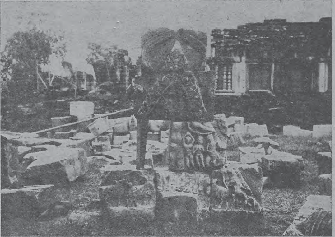
ปรับปรุงรูปร่างของปราสาทหินดิน จนเป็นที่แน่ใจ แล้วจึงนำชิ้นติดต่อกันที่เก็บได้ ภาพบนแสดงการประกอบชิ้นส่วนหน้าบัน ภาพล่างประกอบเครื่องยอดปราสาทประธาน
